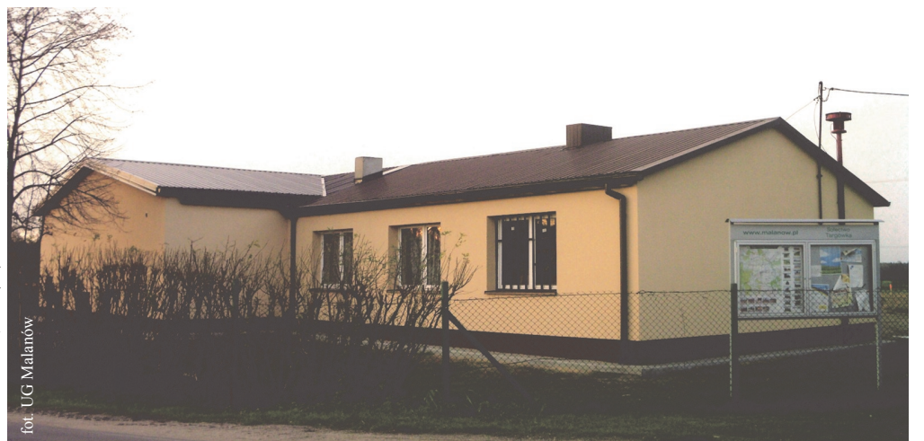
Odnowiony budynek świetlicy wiejskiej
