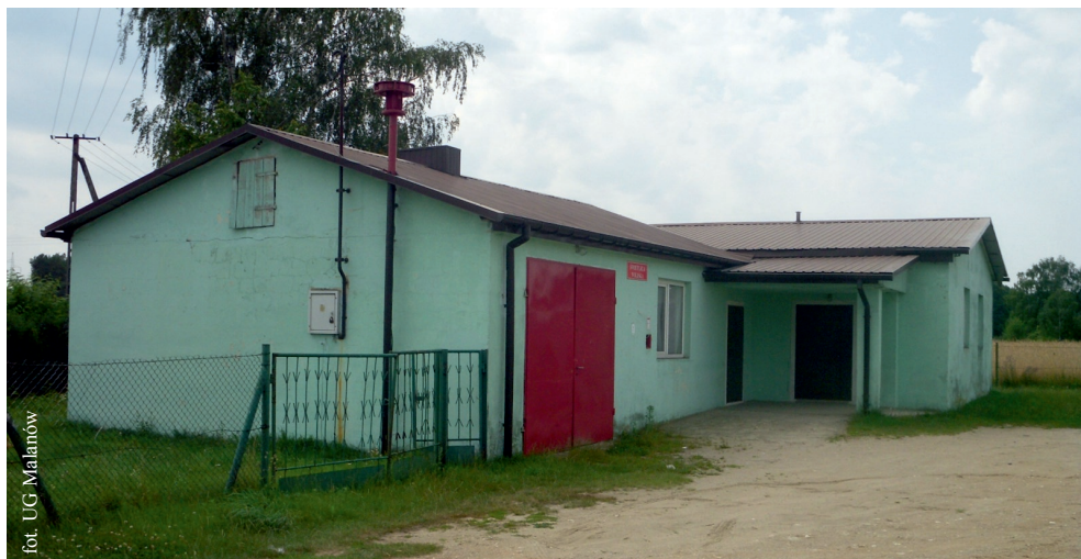
Świetlica wiejska w Targówce przed remontem
